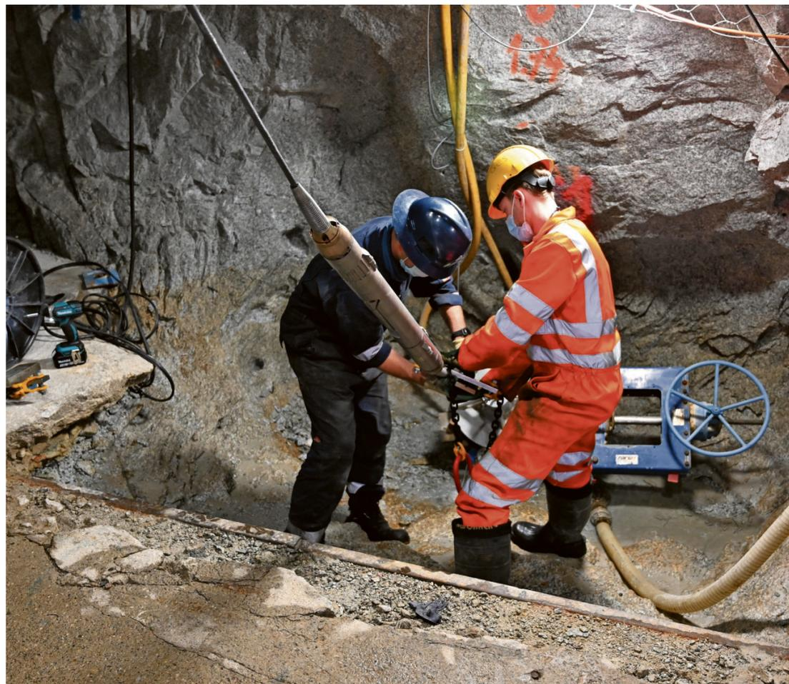
Installation dans le laboratoire de Bedretto de l'ETH de Zurich d'une chaîne de sismomètres dans le forage ST1 afin de surveiller les stimulations dans le forage ST2. Les travaux ont été réalisés sous la direction de Geo-Energie Suisse.
